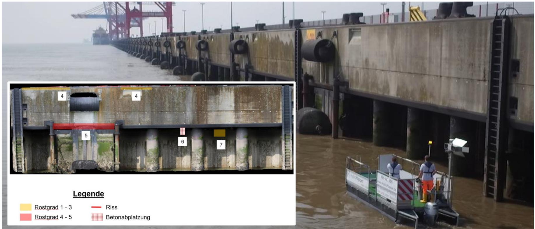
Photogrammetrie / Laser: PW - Stützung
